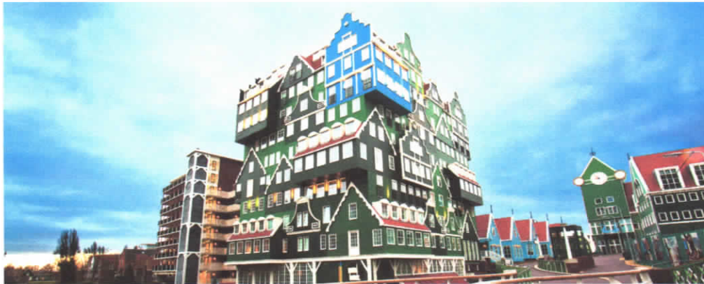
Interessant ist nicht nur die Bauweise des Intel Hotels in Zaandam.
