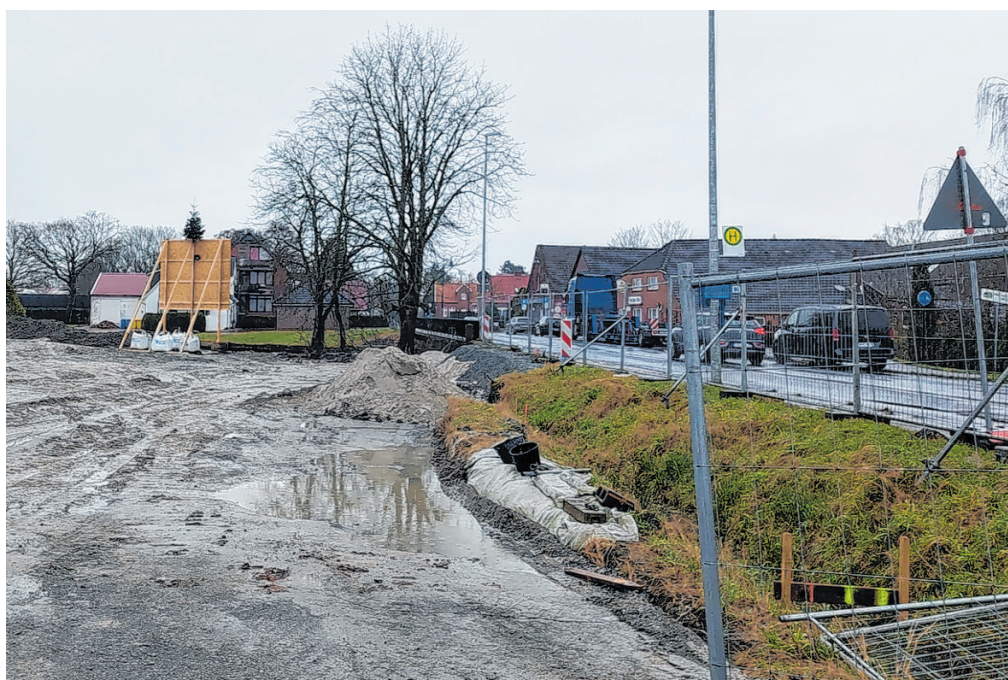
Noch dominiert der Matsch auf dem Grundstück an der Petkumer Straße, auf dem die Senioren-Wohnanlage entstehen soll.
